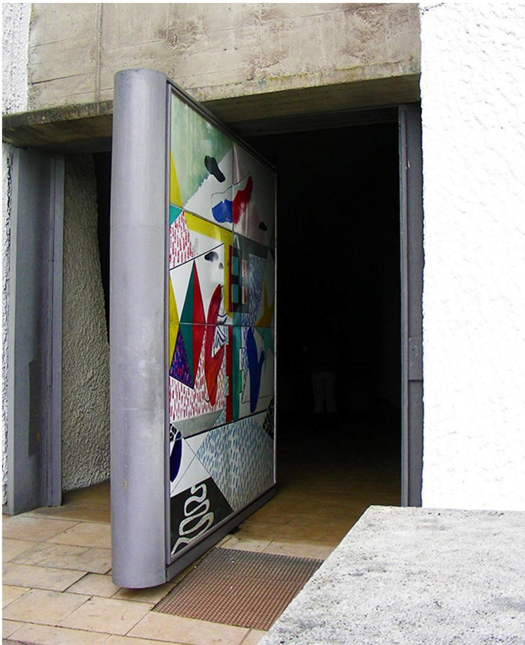
**Figura 25: Portale delle Processioni con apertura a bilico verticale.**
